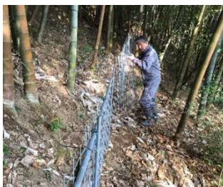
防護柵の設置
